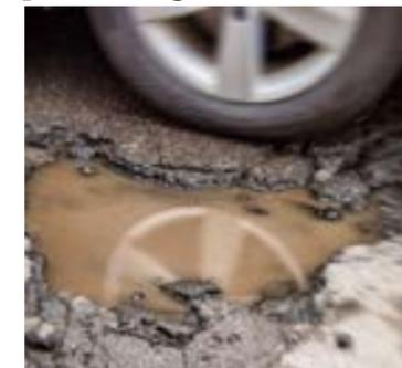
Lorsqu'il fait froid, l'eau gèle et prend de l'expansion, entraînant la chaussée à se courber ou à se fissurer. Lorsque la température est plus clémente, la glace fond et la chaussée se contracte, laissant des espaces dans lesquels l'eau peut s'infiltrer. Si le cycle gel-dégel persiste, la
